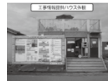
工事情報提供ハウス外観▶P.25
