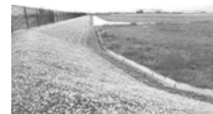
防草緑化工法施工例 (施工後3年経過時点)▶P.27
